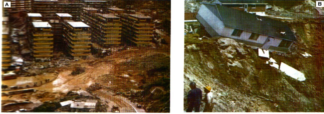
Resim 3. Bir yerleşim biriminde sel baskını ve heyelan sonrası oluşan hasar durumu. A. Yerleşim birimi ve heyelanın görünümü, B. Heyelanın yapılara olan etkisi. Bu alanda arama kurtarma amaçlı elektromanyetik yöntem uygulanmıştır (23).
