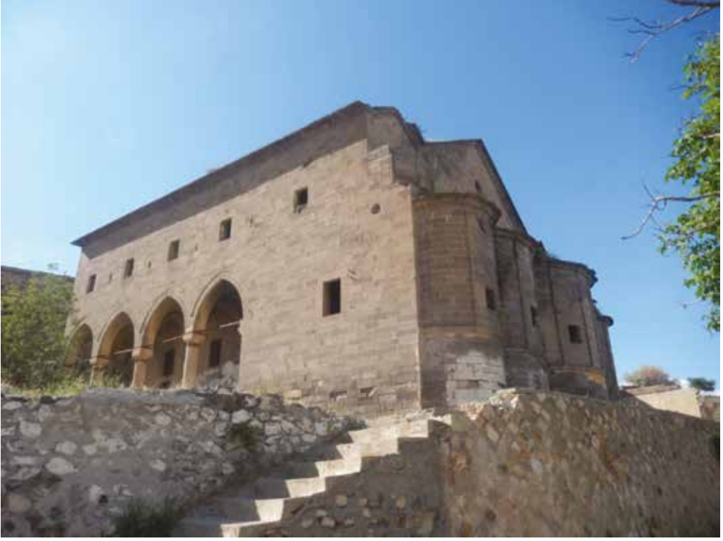
Nevşehir Cezaevi-Kilise'si, dış görünüş. Fotoğraf: Aude Aysin de Tapia, 2014.
