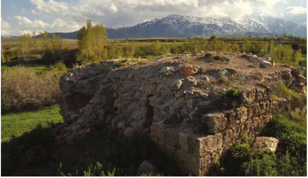
Van Gevaş Dönemeç Köyü Kapenits Asdvadzadin Kilisesi. Van'ın Gevaş İlçesine Bağlı Dönemeç (Ankığ) Köyü kilisesinin günümüzdeki durumu. Fotoğraf: M. Fatih Güden, 2018.
