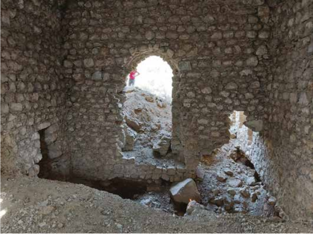
Şemdinli ilçesi Bayn-Ture / Bemtur (Çubuklu)'daki St. George Kilisesi'nin içi, definciler tarafından kaçak kazılar nedeniyle yapının nasıl tehlikeye atıldığını gösteriyor. Fotoğraf: Nicholas Al-Jeloo, 2020.
